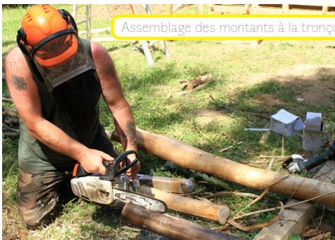
Assemblage des montants à la tronçonneuse
